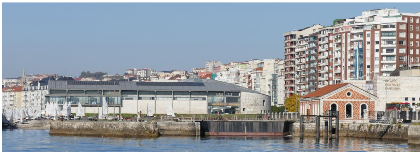
Antiguas instalaciones de Astilleros del Atlántico con su dique seco y casa de bombas. Santander, 7.10.2023
